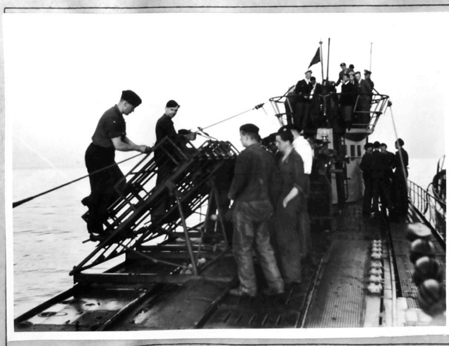
Abb.7: Anbringung der Abschussgestelle auf U 511 am 4.6.1942.
